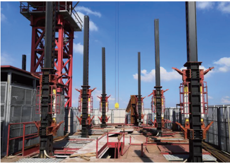
(b) 提升钢柱及液压提升机构
